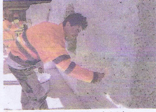
Les maçons commencent par ajouter du sable à la chaux (à gauche). Puis ils utilisent le mélange comme mortier et comme crépi. La finition se fait à la chaux éteinte (à droite).
