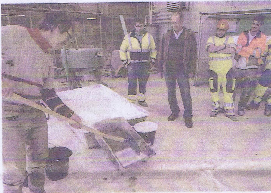
Un maçon «éteint» la chaux vive en la mélangeant à de l'eau, sous l'œil expert de Roger Simond (veste brune).
