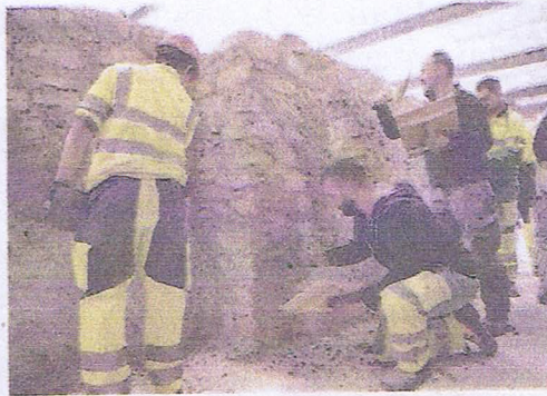
Les maçons commencent par ajouter du sable à la chaux (à gauche). Puis ils utilisent le mélange comme mortier et comme crépi. La finition se fait à la chaux éteinte (à droite).
