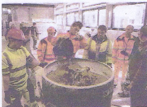
Les maçons commencent par ajouter du sable à la chaux (à gauche). Puis ils utilisent le mélange comme mortier et comme crépi. La finition se fait à la chaux éteinte (à droite).
